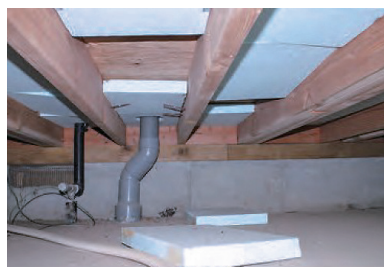
△ 一般隔熱保溫板掉落
