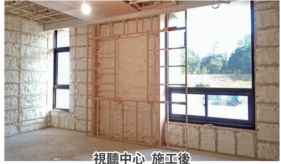
視聽中心 施工後
