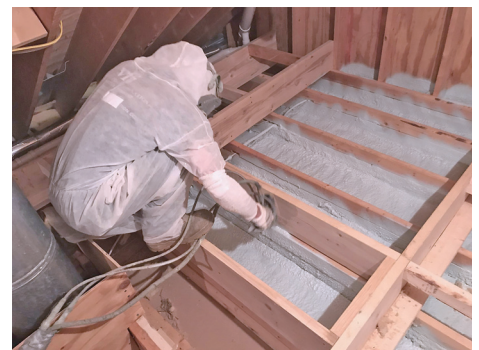
△ 應用在高架地板上，有效阻隔潮氣與溼氣，降低地板受潮而產生發霉現象效果
