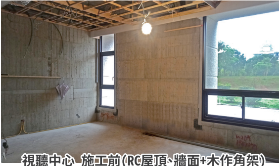
視聽中心 施工前(RC屋頂+牆面+木作角架)
