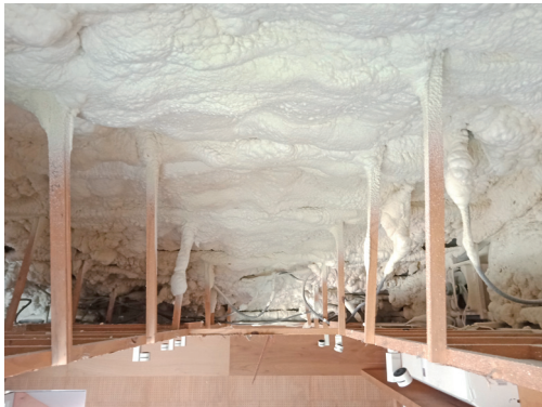
△ 安室能包覆著建築體，阻隔熱輻射或冷空氣，達到室內恆溫的效果
